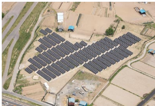
写真は自社物件第4号サンリン千曲発電所で、2013年4月より稼働しております。
