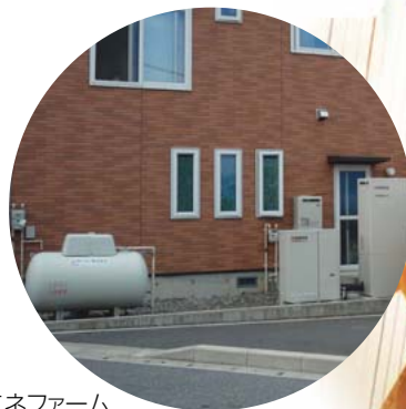
家庭用燃料電池エネファーム
