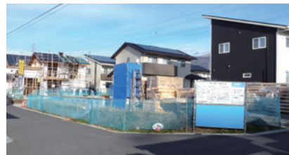
新築着工で賑う塩尻市片丘ニュータウン
