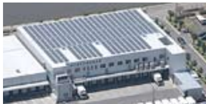
自社物件第2号 サンリン田中製氷発電所
