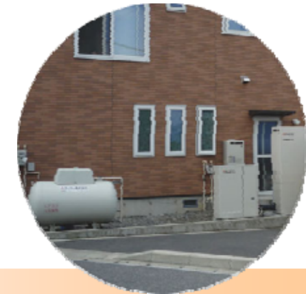
家庭用燃料電池エネファーム
