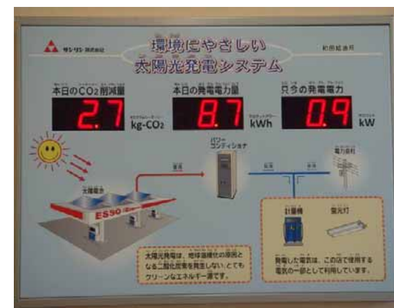
事務所内の発電量表示機器
